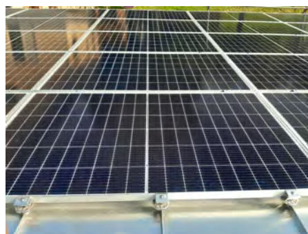
Dachparallele Montage quer zum Falz mit dem S-5!® PV-Kit 2.0 MidGrab : universell als End- und Mittel-Klemme einsetzbar.
