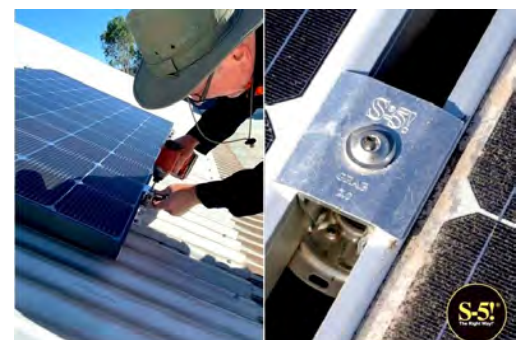
Dachparallele Montage quer zum Falz mit dem S-5!® PV-Kit 2.0 MidGrab : universell als End- und Mittel-Klemme einsetzbar.
