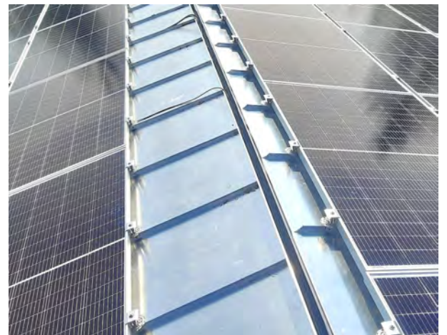
Schienensystem stabil montiert mit S-5!® Z-Mini-FL Klemmen auf Rundfalzdach Direktmontage - ohne Schienen - mit dem S-5!® PV-Kit 2.0
