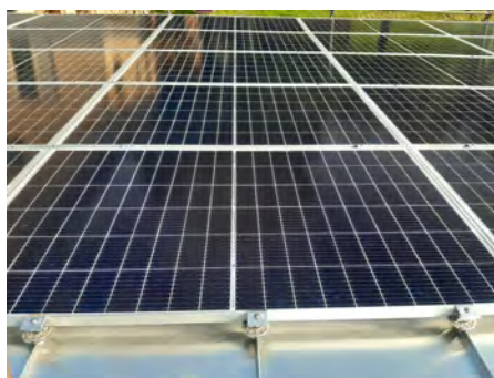
Dachparallele Montage quer zum Falz mit dem PV-Kit 2.0 MidGrab und E-Mini auf Doppelstehfalzdach: universell als End- und Mittel-Klemme einsetzbar.
