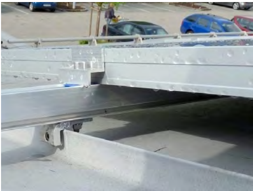
Sistemas de rieles con S-5!® E-Mini-FL en la doble costura de pie y con N1.5-Mini en el pliegue "Nailstrip"
