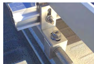
S-5!® Z-Mini montiert mit Winkeladapter an seitlichem Schraubkanal
