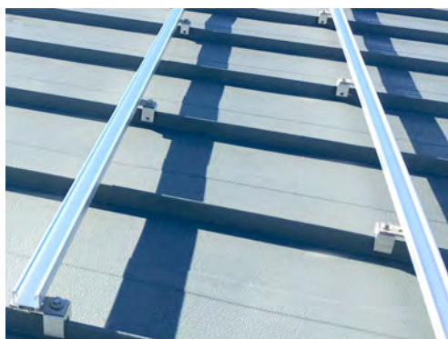
Schienensysteme mit S-5!® E-Mini-FL auf Doppelstehfalz und mit S-5!® S-Mini und Adapterblech auf Snap-Falz
