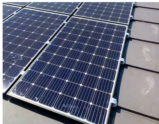
Direktmontage - ohne Schienen - mit dem S-5!® PV-Kit 2.0
