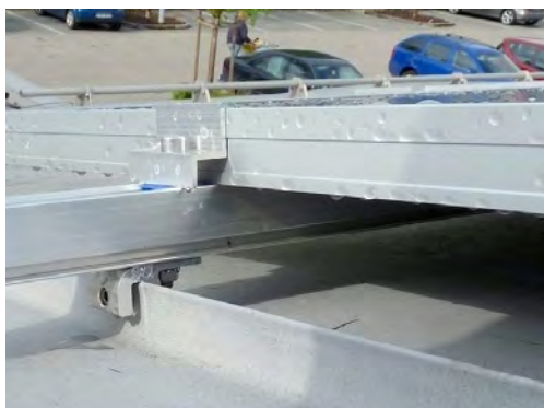
Schienensysteme mit S-5!® E-Mini-FL auf Doppelstehfalz und mit S-5!® S-Mini und Adapterblech auf Snap-Falz
