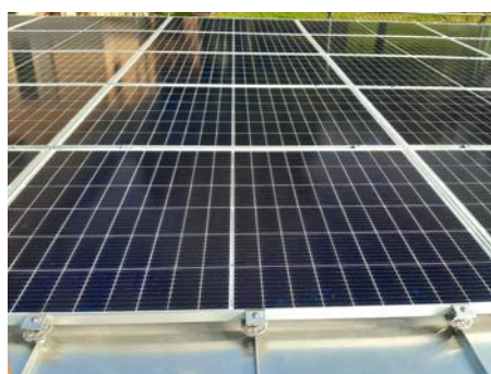
Installation parallèle au toit et protégeant le toit en travers du joint avec le PV-Kit 2.0 MidGrab et E-Mini sur les toits à double joint debout.
