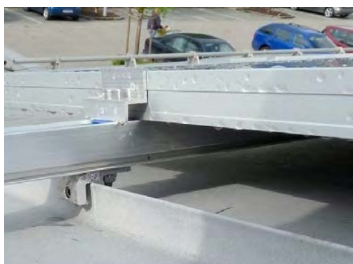
Systèmes de rails avec S-5! E-Mini-FL sur joint debout double et avec S-5! N1.5-Mini sur toit à clous
