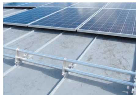
Arrêt neige doubletube sur pince E-Mini sur toiture à joint debout
