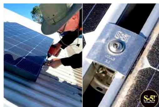
Installation parallèle au toit et protégeant le toit en travers du joint avec le PV-Kit 2.0 MidGrab et E-Mini sur les toits à double joint debout.
