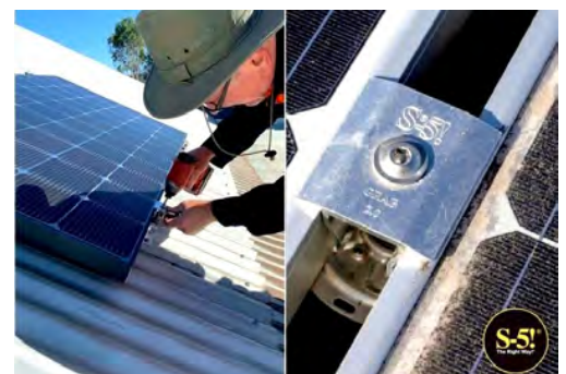
Dachparallele Montage quer zum Falz mit dem PV-Kit 2.0 MidGrab und E-Mini auf Doppelstehfalzdach: universell als End- und Mittel-Klemme einsetzbar.
