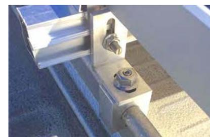
S-5!<sup>®</sup> Z-Mini monté avec adaptateur d'angle sur le canal latéral à vis
