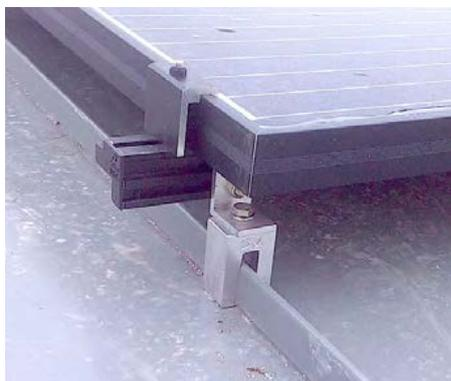
Systèmes de rails avec S-5!<sup>®</sup> E-Mini-FL sur joint debout double et avec S-5!<sup>®</sup> N1.5-Mini sur toit à clous
