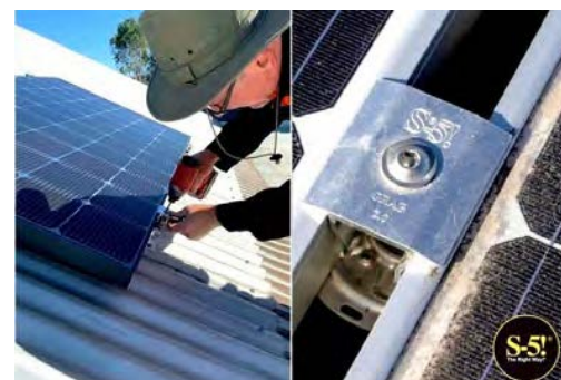
S-5!® PV-Kit 2.0 MidGrab montato su S-5!® Mini-Clamp
