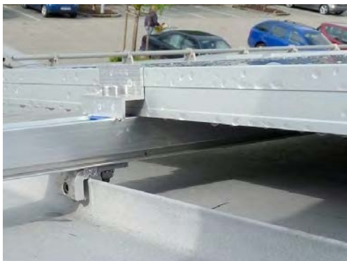
Binari montati con S-5!® E-Mini-FL su doppia cucitura in piedi e con S-5!® N1.5-Mini su cucitura di Nail-Strip.
