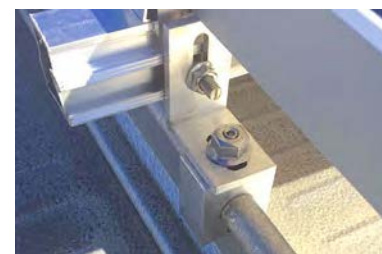
S-5!® Z-Mini montato con adattatore angolare su canale laterale a vite.
