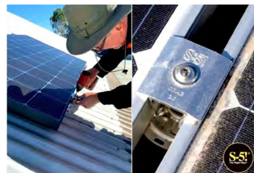
Instalación en paralelo al techo en ángulo recto con la junta con el PV-Kit 2.0 MidGrab y E-Mini en techos de doble junta de pie: puede utilizarse como pinza final y media.
