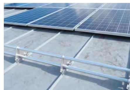
Soporte doble de tubo montado con abrazaderas S-5!® Mini en un techo con doble costura pleada
