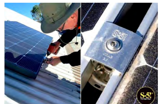
Dachparallele Montage quer zum Falz mit dem PV-Kit 2.0 MidGrab und E-Mini auf Doppelstehfalzdach: universell als End- und Mittel-Klemme einsetzbar.
