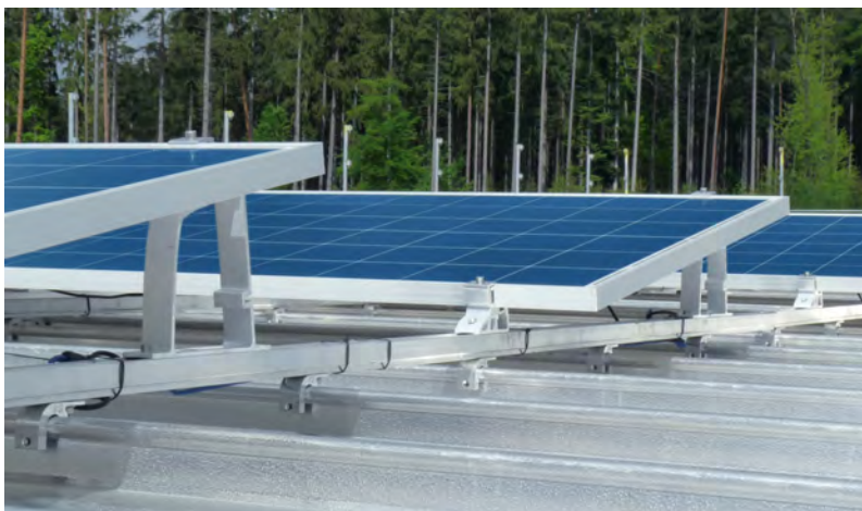
Schienensystem stabil montiert mit S-5!® Z-Mini-FL Klemmen auf Rundfalzdach
