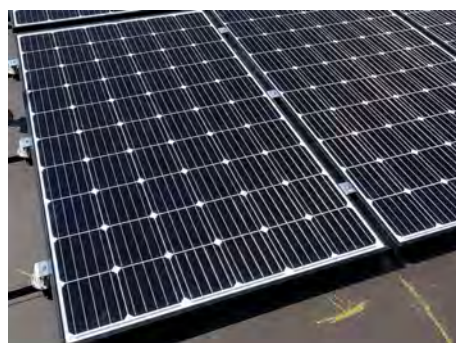
Dachparallele Montage quer zum Falz mit dem PV-Kit 2.0 MidGrab und E-Mini auf Doppelstehfalzdach: universell als End- und Mittel-Klemme einsetzbar.
