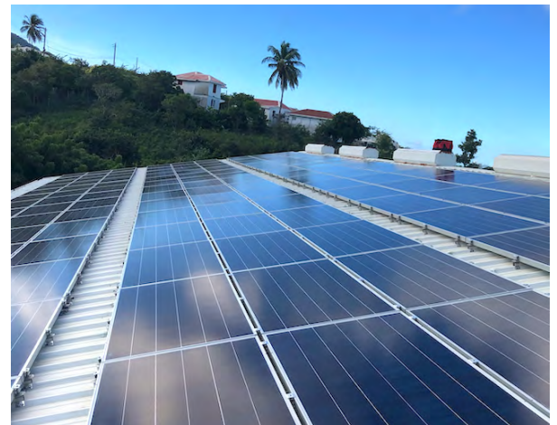
Direktmontage - ohne Schienen - mit dem S-5!® PV-Kit 2.0
