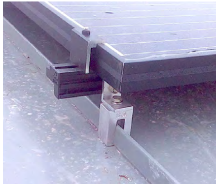
Schienensysteme mit S-5!® E-Mini-FL auf Doppelstehfalz und mit S-5!® N1.5-Mini auf Nailstrip-Falzdach
