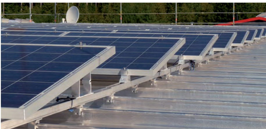
S-5!® Z-Mini-FL Klemmen: die stabile Basis für Schienensystem auf Rundfalzdach.
