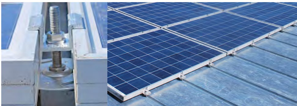
Dachparallele Montage quer zum Falz mit dem PV-Kit-Alu und E-Mini auf einem Doppelstehfalzdach
