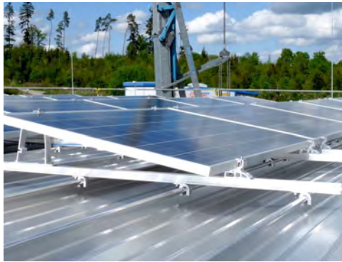
Schienensysteme mit S-5!® E-Mini auf Doppelstehfalz- und mit S-5!® Z-Mini-FL auf einem Rundfalz-Dach.
