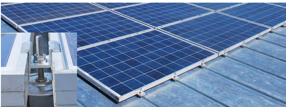
Liegende Montage der Module, quer zum Falz, mit S-5!® PV-Kit auf S-5!® Mini-Klemme
