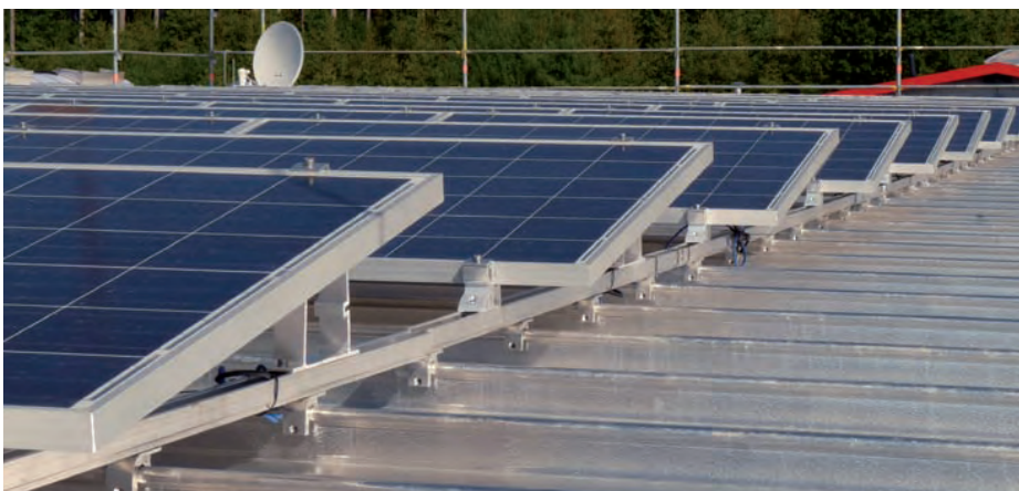
S-5! Z-Mini-FL unter Schienensystem auf Rundfalzdach
